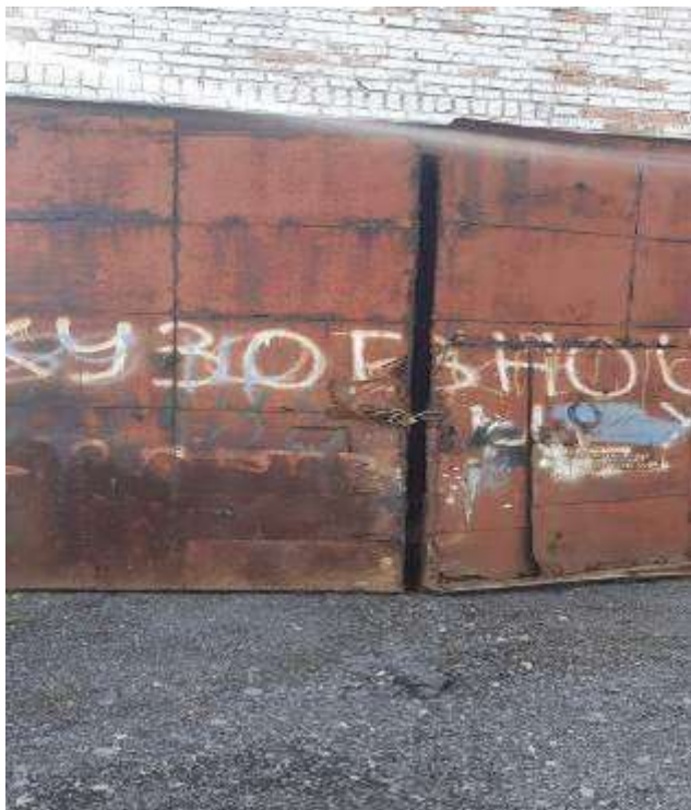
Дверь в помещение фото 49
