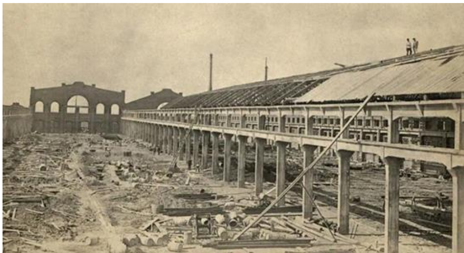
Строительство меднопрокатного завода
